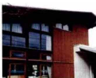
写真2 軒裏に使用された木材(月経くまもと空透) 軒裏は日当たりと雨降りが少ないため、比較的(つくば市立東小学校) 透明性の高い塗装でも劣化が緩やか。
