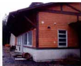
写真4 軒やけらばの出による保護効果の例 (栃木県21世紀林業創造の森訓練棟) さらに基礎が高い場合には雨水の跳ねも少なく 保護効果がより高まる。
