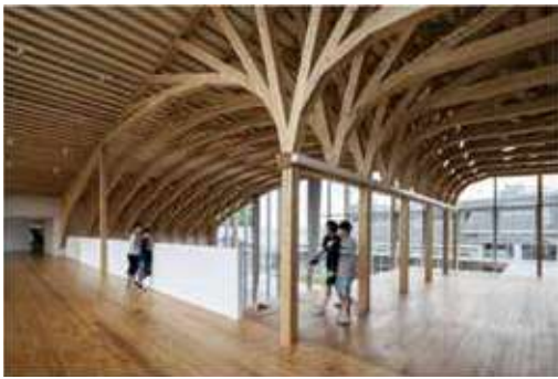
■混構造（鉄筋コンクリート造+木造） 山鹿市立山鹿小学校 オープンスペース 資料：シーラカンスK&H（株）HP より
