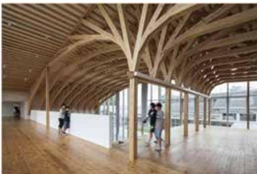
■混構造（鉄筋コンクリート造+木造）
